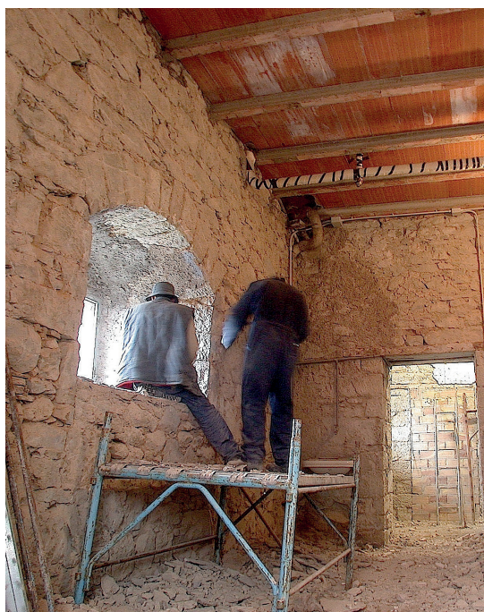
Agosto 2004; iniziano i lavori di ristrutturazione dei Fondi comunali.
