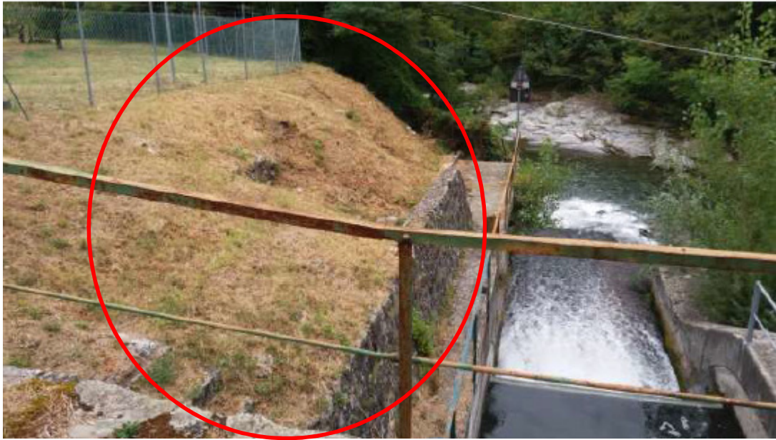
Figura 8: Canale di scarico esistente ed area proposta per installazione turbina.
