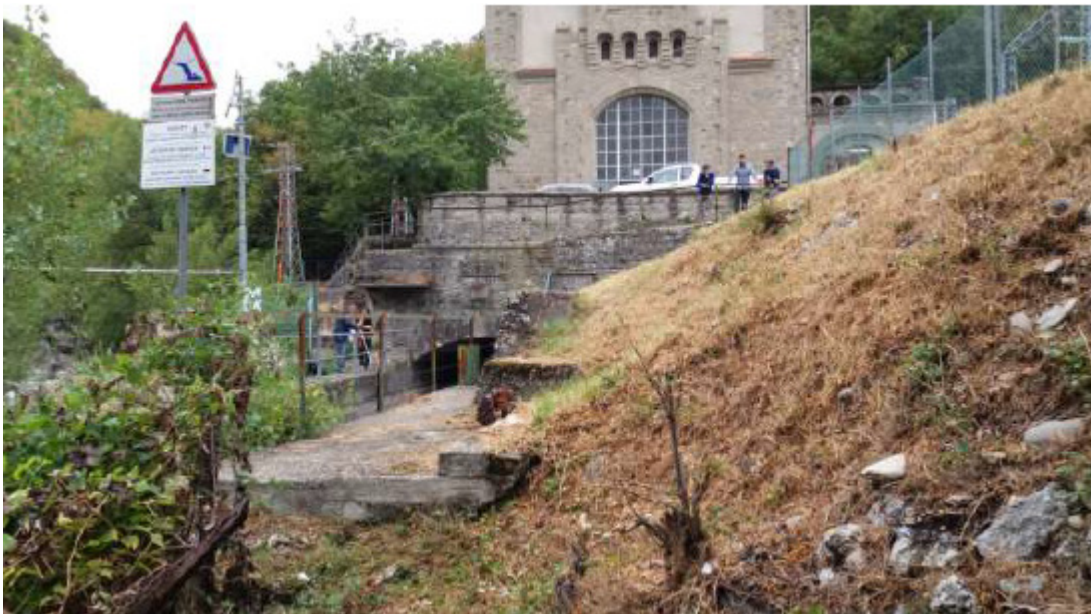
Figura 9: Area installazione coclea.
