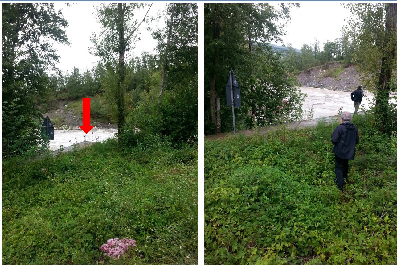
Figura 40 Vista della briglia da lato laghetti-edifici esistenti
