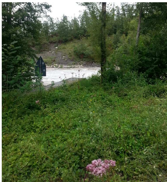
Foto 2 – Area posta in prossimità della briglia
