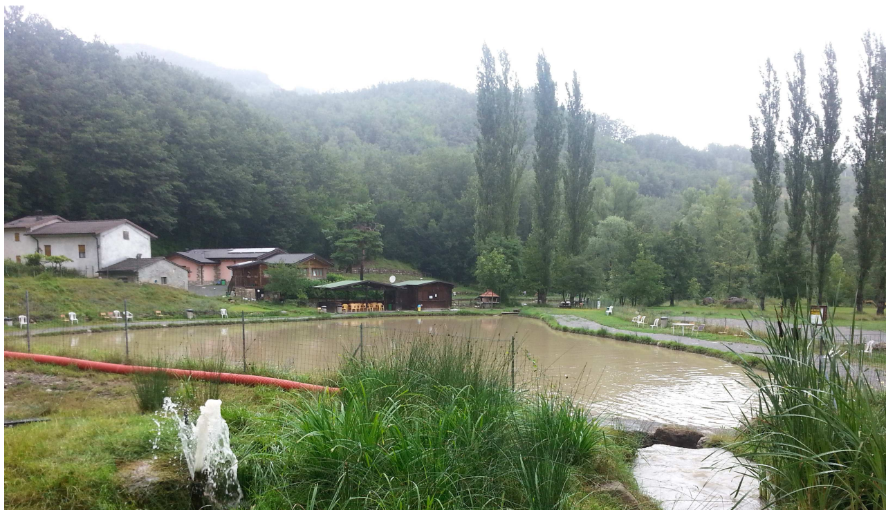
Figura 5 Vista dei laghetti e degli edifici esistenti (in sinistra idraulica)
