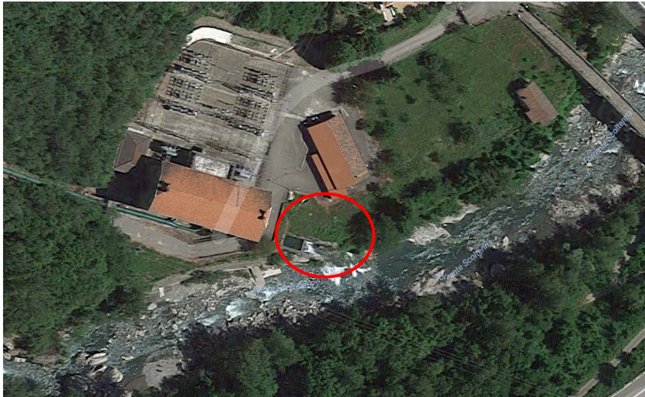
Figura n. 01 – Ortofoto centrale idroelettrica esistente
