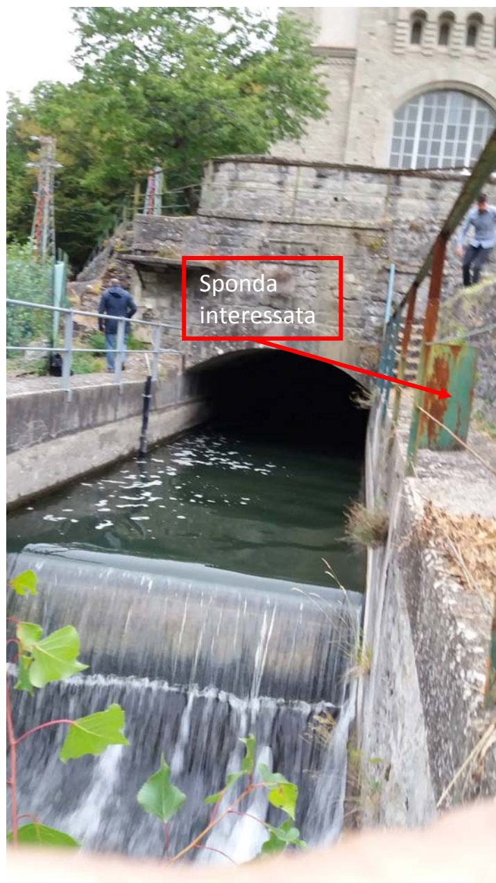
Figura n. 03 – Canale di scarico esistente
