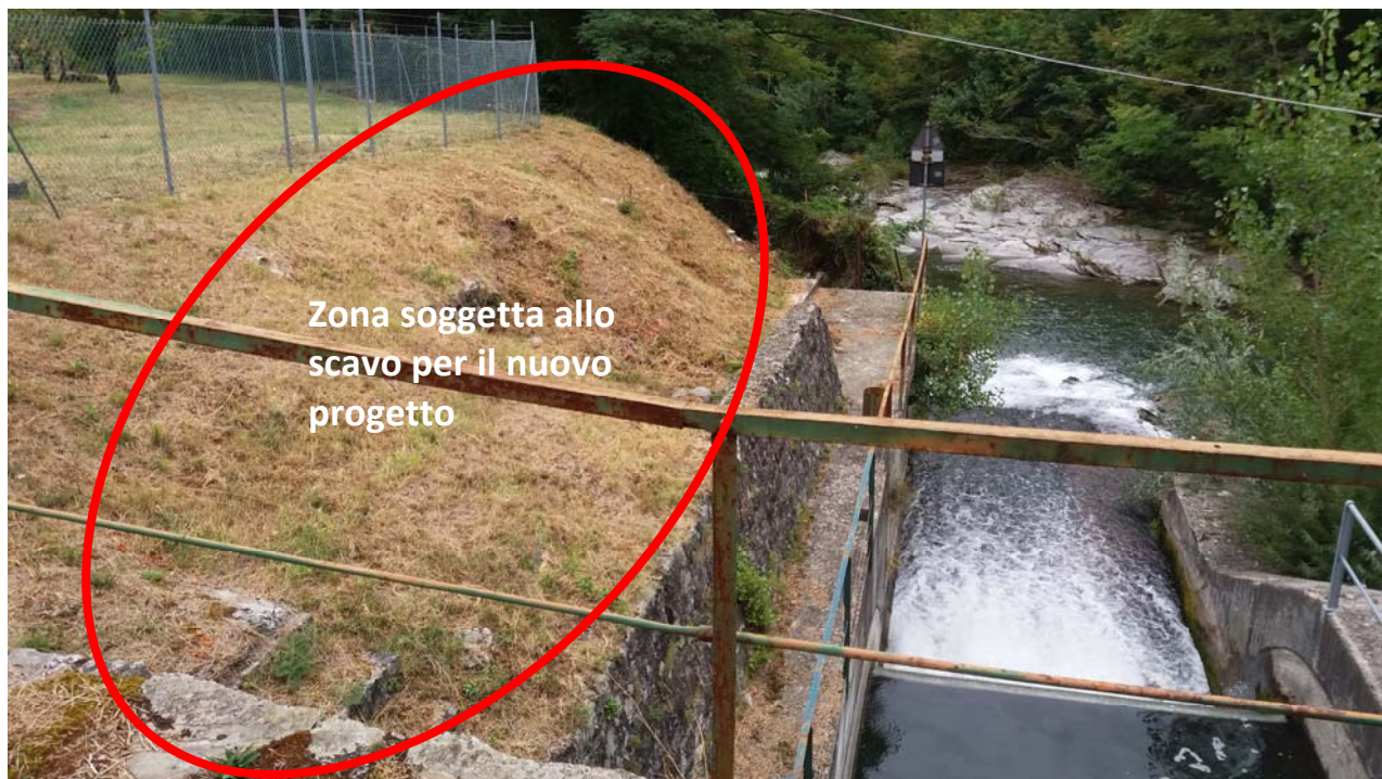
Figura n. 04 – Canale di scarico esistente e area proposta per installazione turbina a coclea (lato sinistro canale di scarico)
